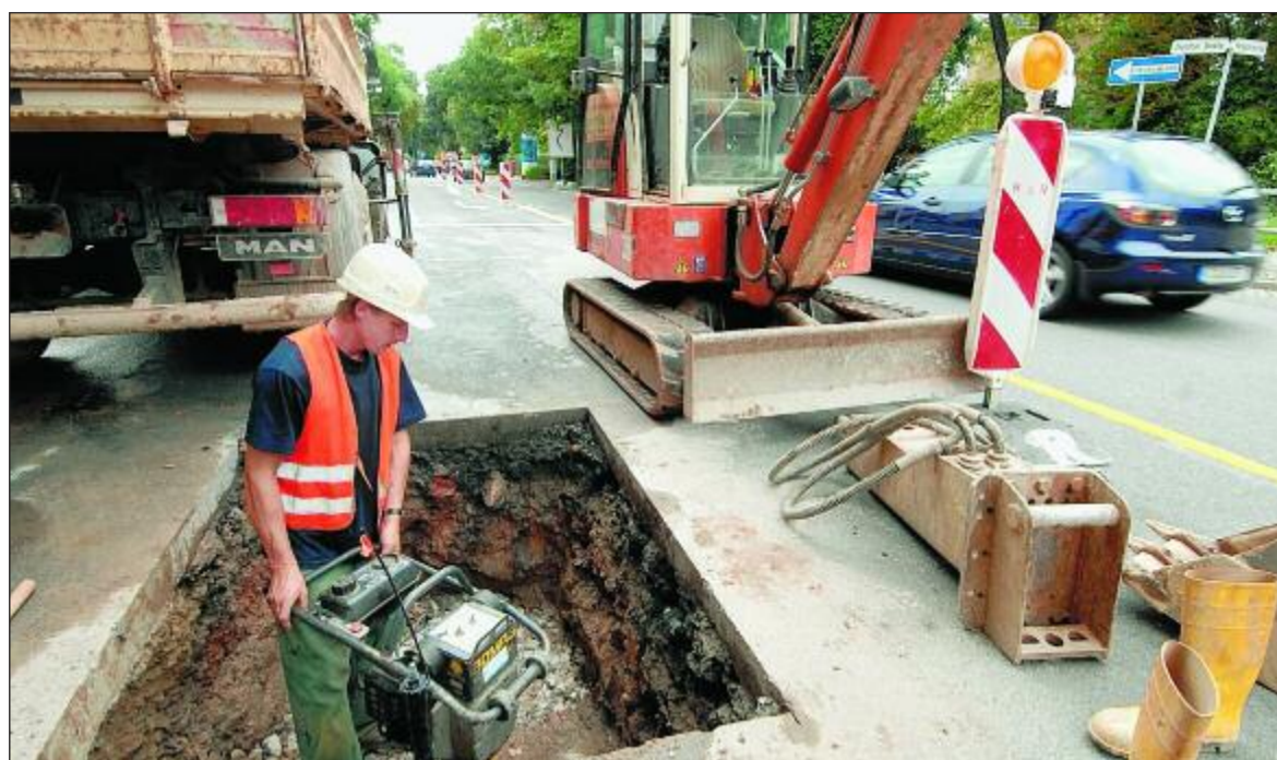
Mit Hochdruck arbeiteten gestern Beschäftigte der Firma Rohrleitungsbau Altchemnitz (im Bild: Matthias Schön) auf der Dresdner, nahe der Margaretensstraße. Der Abschnitt war wegen eines Rohrbruchs gesperrt. –FOTO: A. SEIDEL
